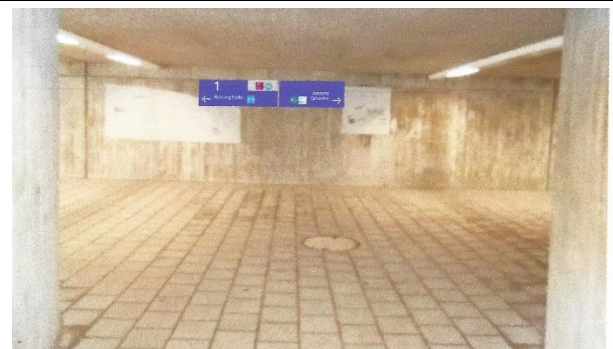
Beschilderung vom Bahnsteig 3 in die Unterführung
